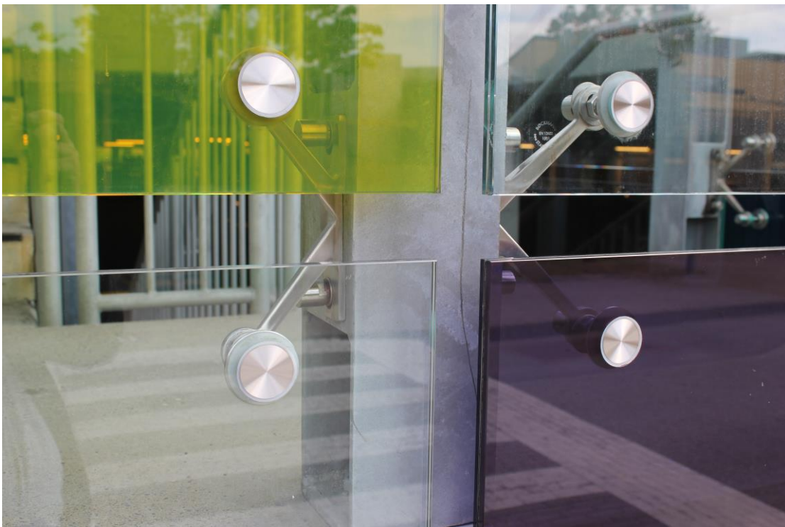
Bilder fra trappehus hos Statoil i Stavanger
